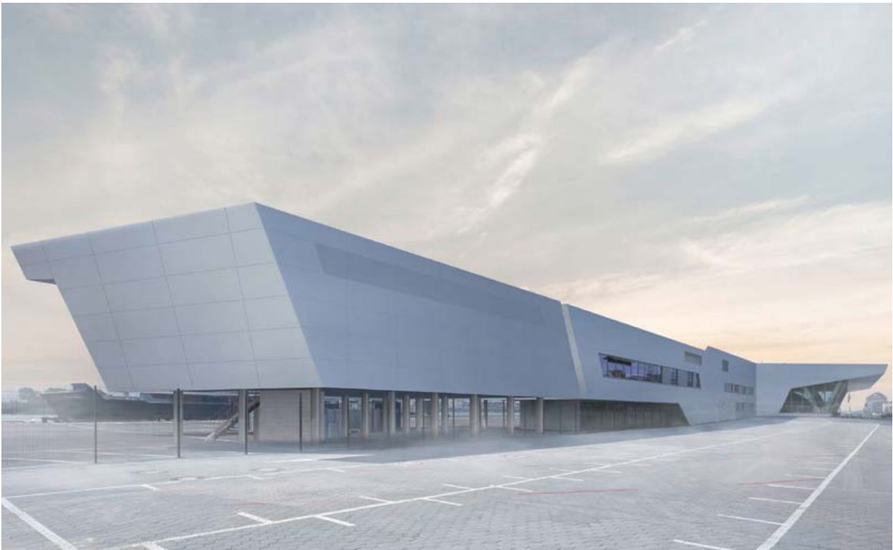
Hamburgs Luft muss sauberer werden, so das Urteil eines Hamburger Verwaltungsgerichts. Die zehn Millionen Euro teure Landstromanlage am Kreuzfahrtterminal Altona mit Anlegemöglichkeit für Schiffe bis 300 Meter soll dazu beitragen. In die Umformerstation werden vier Transformatoren und ein Spannungswandler eingebaut.
